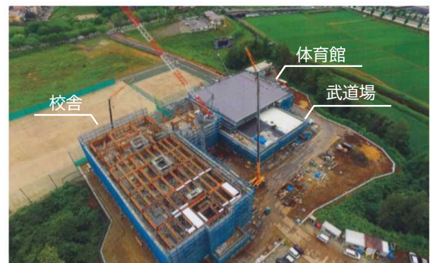
③ 平成30年6月:体育館の屋根が見えてきました。
